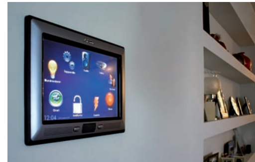
Il touch-screen AMX da incasso installato nel soggiorno è uno strumento completo per il controllo dell'impianto sia in locale, sia da remoto quando si è fuori casa
