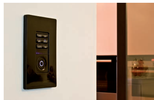
Ciascuna zona della casa è dotata di un tastierino della serie Metreau di AMX, da cui è possibile gestire le numerose sorgenti dell'impianto
